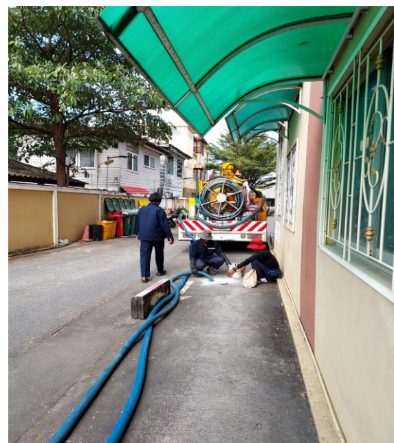
รูปที่ 9 การสูบล้างจากระบบบำบัดน้ำเสียสำเร็จรูป
