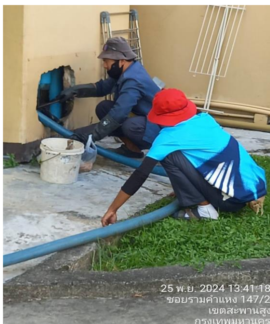
รูปที่ 9 การสูบล้างจากระบบบำบัดน้ำเสียสำเร็จรูป
